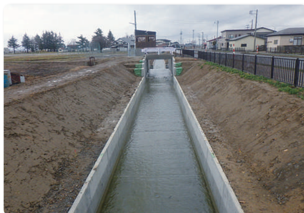
コンクリートフリーム水路に改修しました
