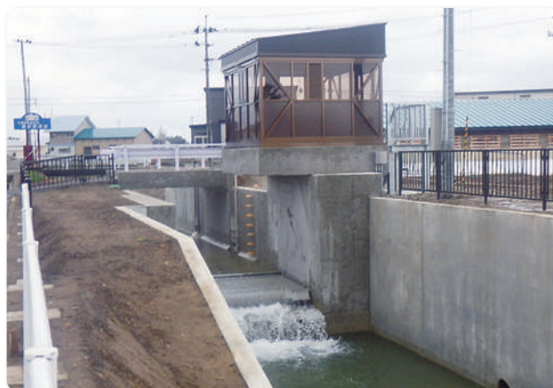
改修後の上屋及びゲート（八幡川分水工）
