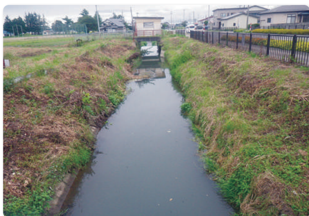
施工前の張りブロック水路の状況
