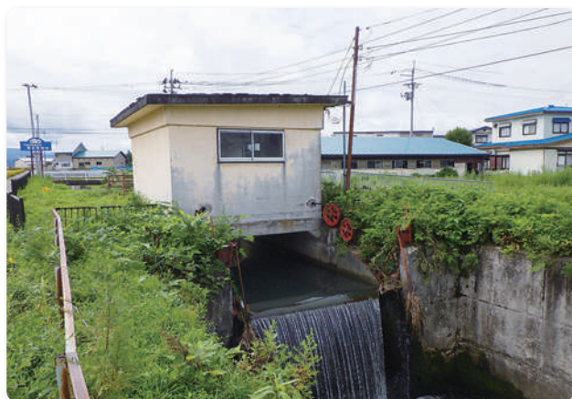
施工前の上屋及びゲートの状況（八幡川分水工）
