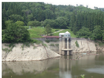
皆瀬ダム水位(R6.6.18撮影)
