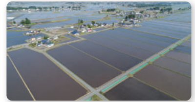
■朴田荒処地区:整備後(R5)
