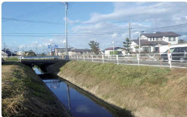
施工前の張りブロック水路の状況
