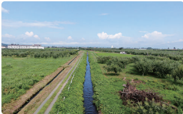
施工前の張りブロック水路の状況
