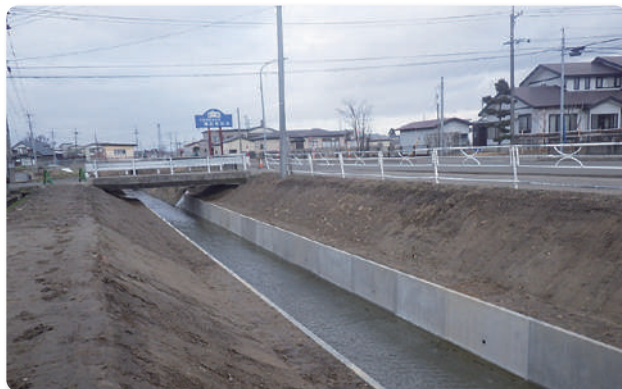
コンクリートフリューム水路に改修しました
