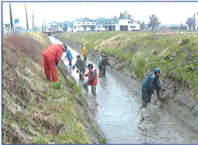
【春の浚渫作業】M3幹線用水路
