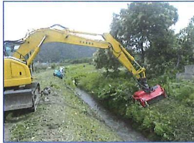
【草刈り作業】N2用水路
