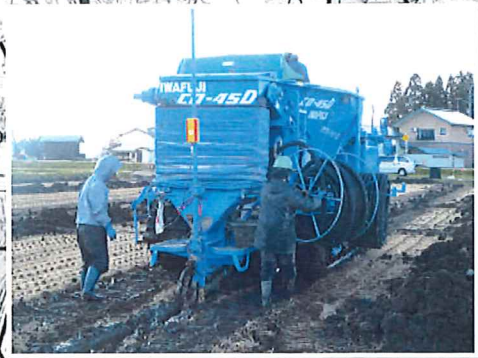
田ノ植地区 RD 工法 (非開削) 暗渠工事
