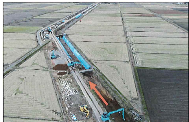
②皆瀬3号幹線用水路(横手市平鹿町下鍋倉字関根小屋地内)
