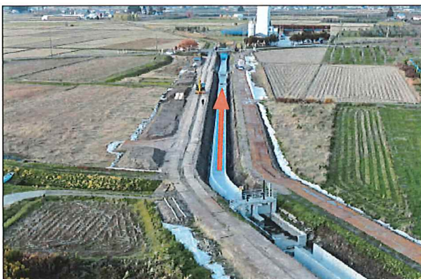
①成瀬1号幹線用水路(横手市増田町増田字樋場南地内)
