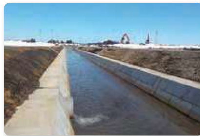
積ブロック護岸に改修しました。
