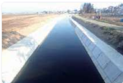
積ブロック護岸に改修しました。
