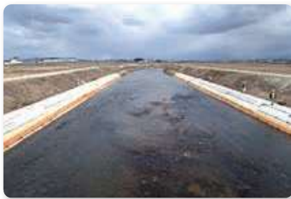
連節ブロック護岸に改修しました。
