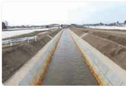
積ブロック護岸に改修しました。
