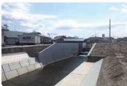
分水工を全面改修しました。
