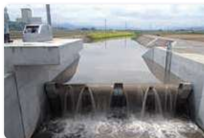
分水工を全面改修しました。
