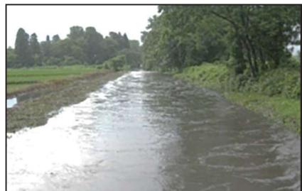
【五郎兵衛排水路の大雨時】
