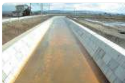
積ブロック護岸に改修しました。
