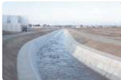
積ブロック護岸に改修しました。
