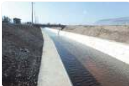
積ブロック護岸に改修しました。
