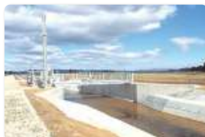
分水工（ゲート）を全面改修しました。
