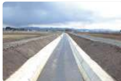
積ブロック護岸に改修しました。
