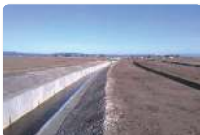
大型フリューム水路に改修しました。
