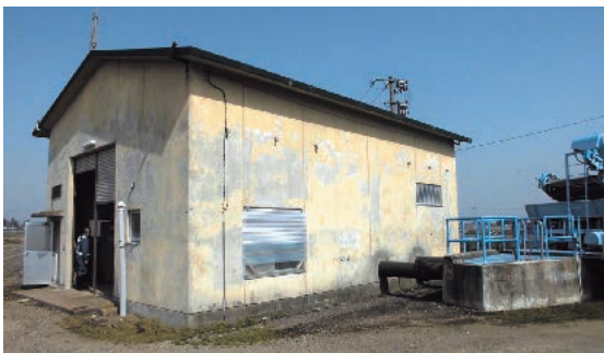
【大雄揚水機場 全景】
