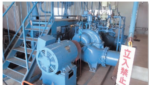
【主ポンプ及び電動機 工場整備】
