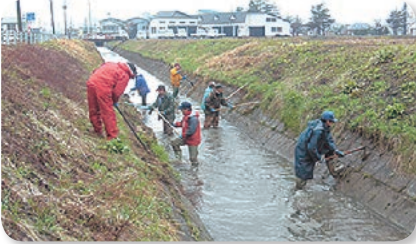
【春の浚渫作業】 M3 幹線用水路
