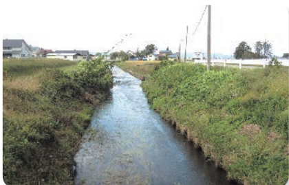
皆瀬3号幹線用水路
