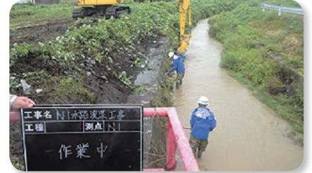
【機械浚渫作業】 N1 幹線用水路
