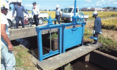
大雄精兵村地区活動組織 ゲート塗装工事
