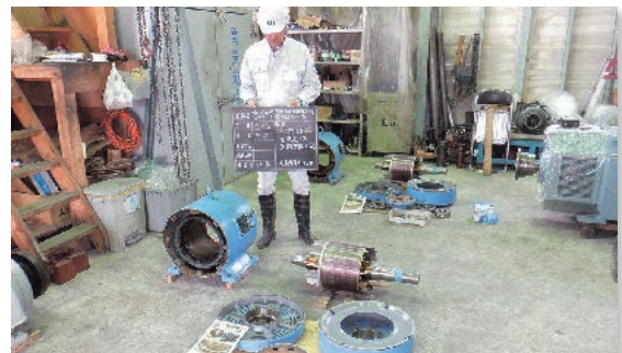
【電動機分解整備状況】
