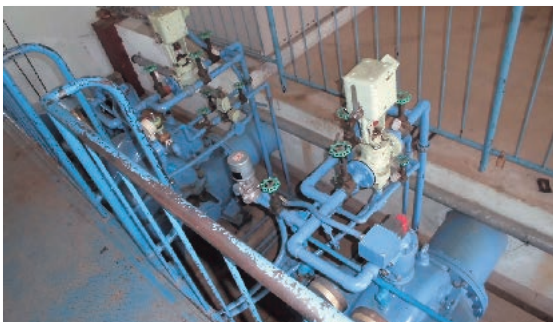
【小配管類整備】
