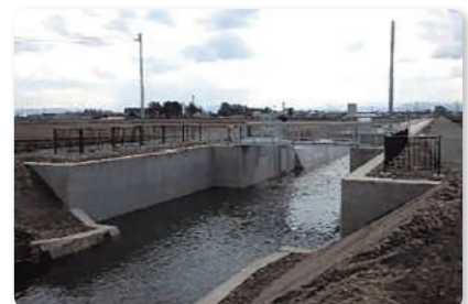
石持川幹線排水路 (焼石分水工)
