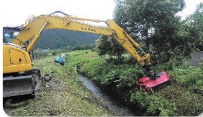
【草刈り作業】 N2 用水路
