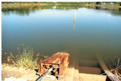
【既設スクリーン腐食状況】
