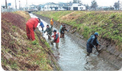
【春の浚渫作業】 M3 幹線用水路
