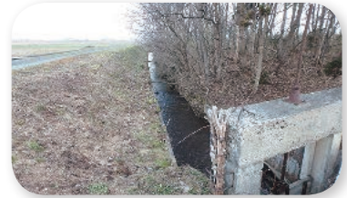
■皆瀬(1)地区:M5-3(施工前)
