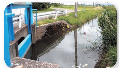
■皆瀬(2)地区:M2-5-1(施工前)
