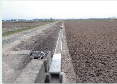
水路の更新（実施後）
