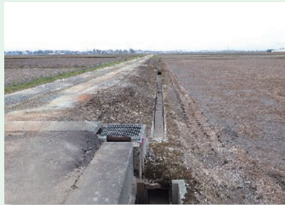
阿気地域農地・水・環境保全組織 水路の更新（実施前）
