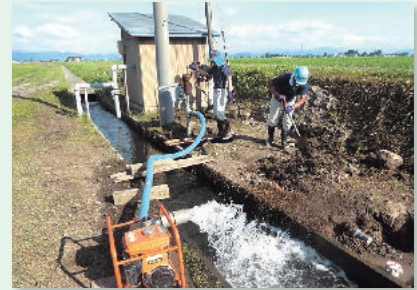
ゲート類等の保守管理
