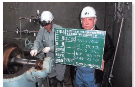
【スリーブ摩耗状況】
