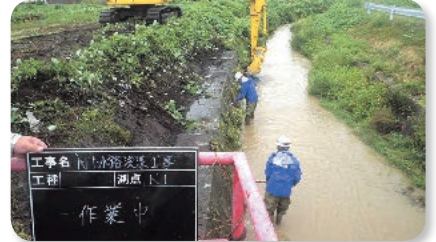
【機械浚渫作業】 N1 幹線用水路
