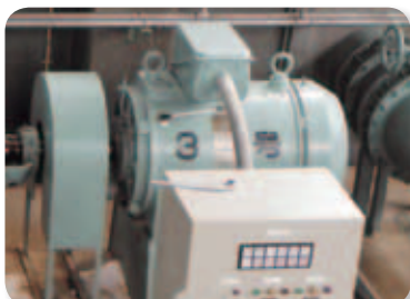
【電動機工場整備（N=1台）115kw×725rpm
