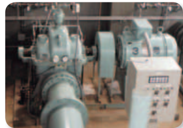
【主ポンプ3号機工場整備（N=1台）φ500mm×115kw
