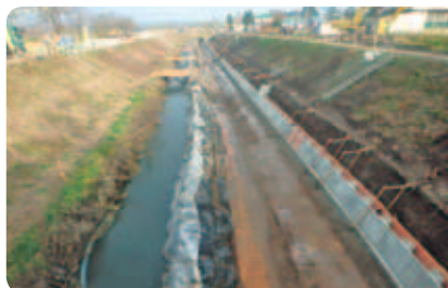
大宮川幹線排水路
