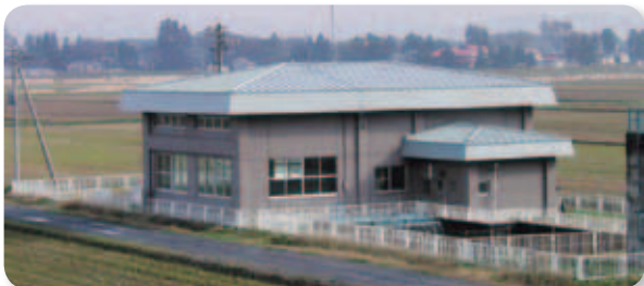
【開三ヶ村揚水機場（全景）】
