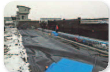
■金屋地区 補助暗渠
