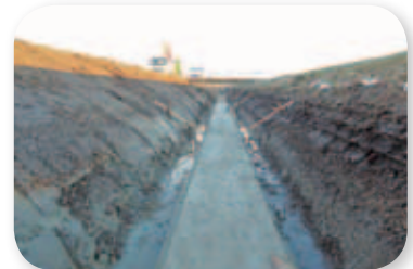
■平鹿南部地区 ゴム堰補修
