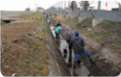
【春の浚渫作業】 皆瀬2号幹線用水路
