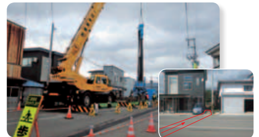
皆瀬1号幹線用水路
