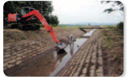
【機械浚渫作業】 M6-4 用水路
