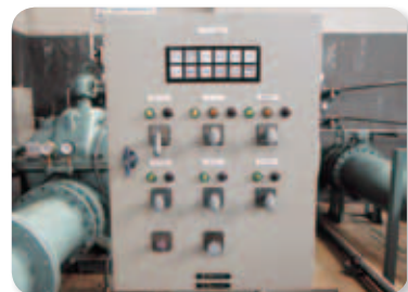
【操作盤更新（N=1面）】
