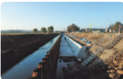
油川幹線排水路
