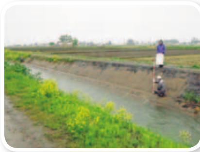
M3張りブロック補修工事 【延長 L = 30m】 (横手市平鹿町浅舞字研町地内)
