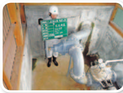
一ッ屋揚水機補修工事 【両端フランジ直管 φ200・スルース弁 10 k - 200 取替】 (横手市十字町植田字一ッ屋地内)
