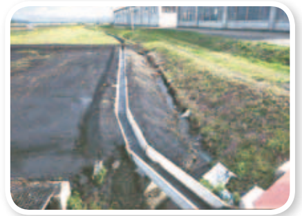
田村野地区 水路補修工事【延長 L = 17 m】 (横手市大雄字森岡南地内)
