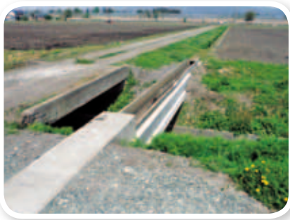
田根森地区 若宮幹排掛樋補修工事 【延長 L = 5 m】 (横手市大雄字下根田谷地内)
