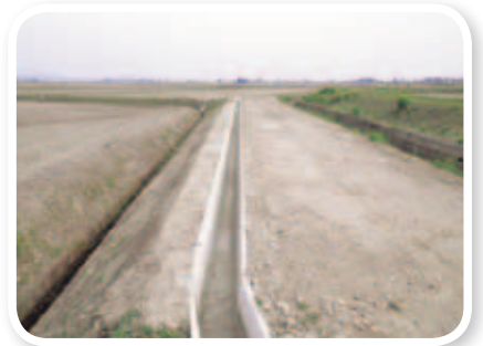
十字地区 用水路改修工事【延長 L = 40 m】 (横手市睦合字起臥地内)
