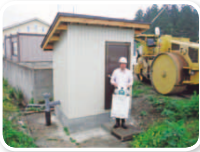
真角揚水機更新工事 【地上ポンプ φ80×2.2 kw・掘削延長 L = 22 m】 (横手市平鹿町上吉田字真角地内)
