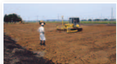
軟弱地盤への基盤土搬入
