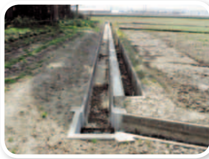
田根森地区 フリーム布設替及び樹設置工事 【延長 L=L34m・樹 2ヶ所】 (横手市大雄字八柏家間地内)
