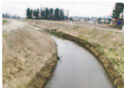
大宮川幹線排水路
