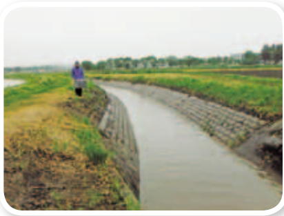
泥鰯沼堰排水路浚渫工事 【延長 L = 550m】 (横手市大雄字折橋地内)
