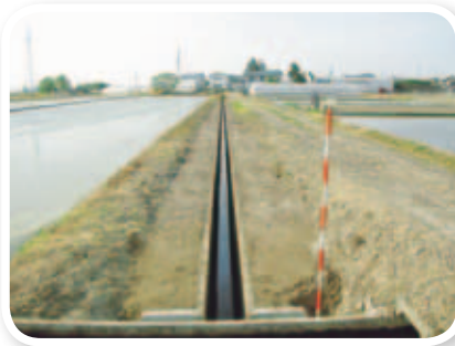
十字地区 排水路改修工事【延長 L=62 m】 (横手市十字町鼎字大倉地内)
