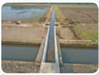
平鹿地区 掛樋更新工事【3箇所】 (横手市平鹿町下吉田字除下夕地内)
