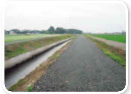
M3-3管理道路補修工事 【延長 L = 900m】 (横手市平鹿町下吉田字一本杉堂ノ後地内)
